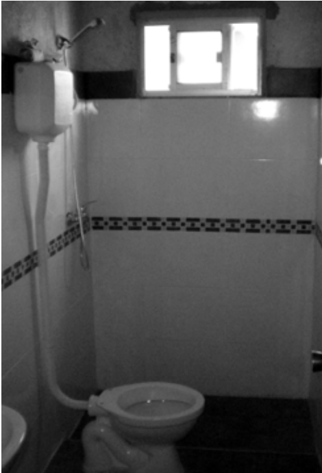
12. Baño por estrenar, en la nueva vivienda.
