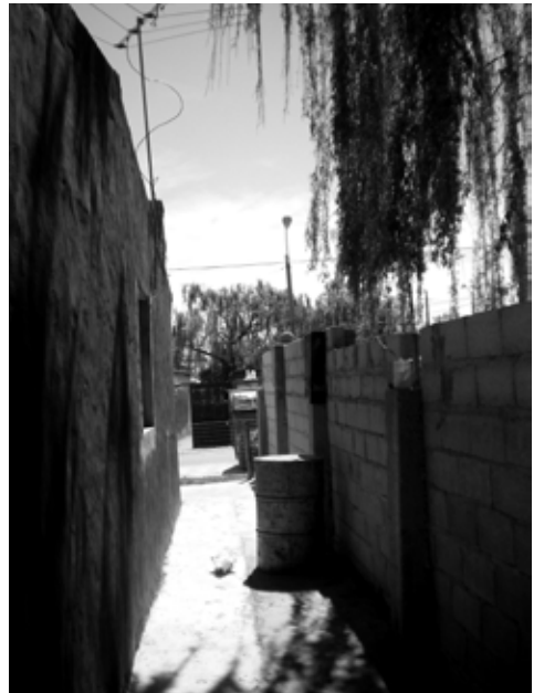
22. Corredor lateral con muro en medianera.
